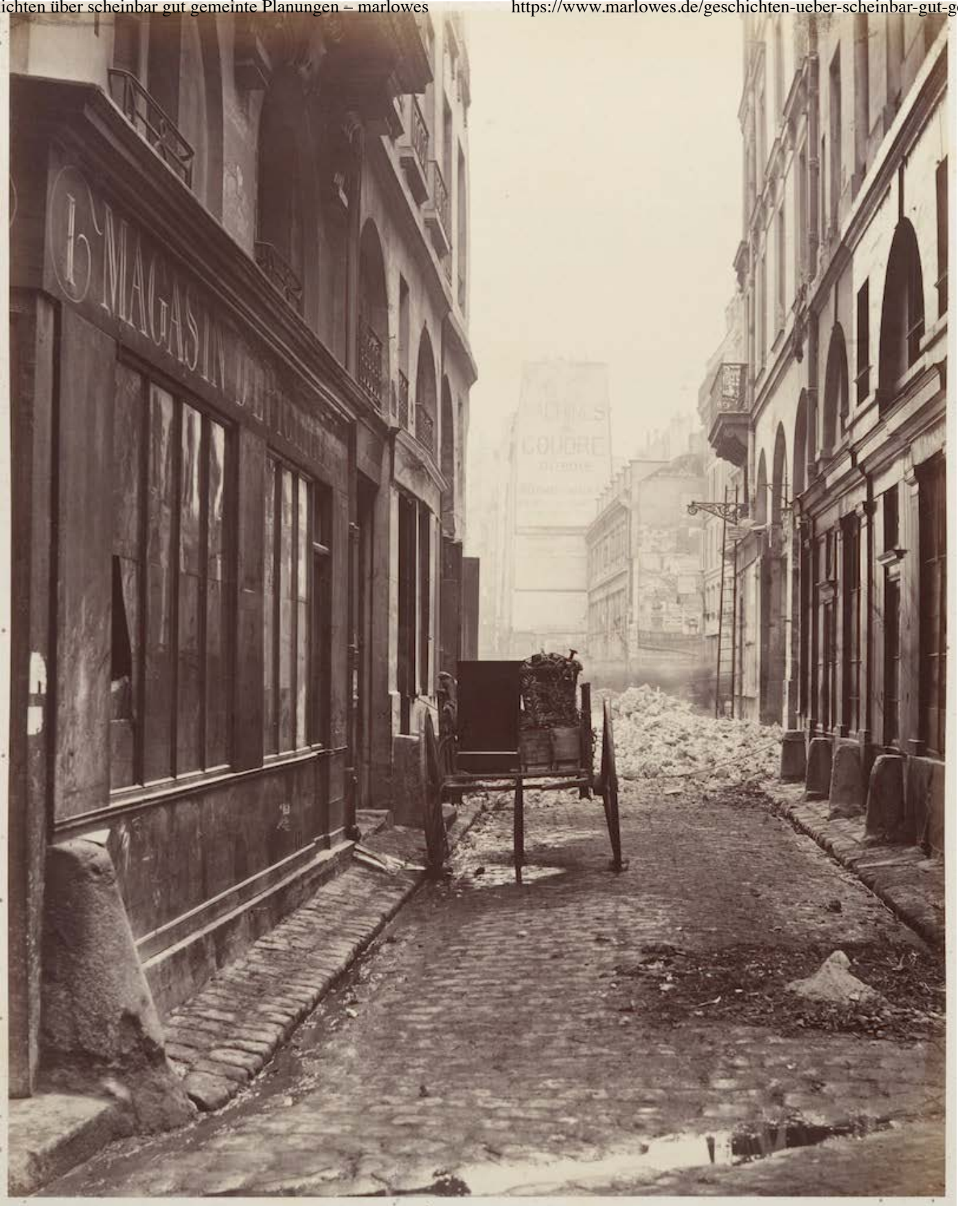
Rue Estienne, de la rue Boucher 1862–65. Die Gebäude entlang der Rue Estienne werden abgerissen, um Platz für die Rue du Pont-Neuf zu machen. Fotografie von Charles Marville, der beauftragt worden war die massive Transformation von Paris zu dokumentieren. (Bild: Gilman Collection, Purchase, Mr. and Mrs. Henry R. Kravis Gift, 2005 )
